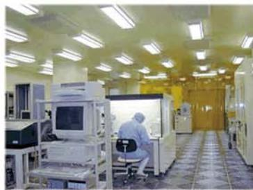
산업용 크린룸 (Industrial Clean Room)은 반도체 산업 뿐만 아니라 정밀기기, 광학기기, 자기테이프, 사진용 필름, 인스턴트 식품의 제조와 포장, 특수인쇄 등에 이르기 까지 폭넓게 이용되며, 요구되는 청정도 또한 각각의 규정에 따라 상이하게 구분됩니다. 그리고 Clean Room은 외부로부터 진입 입자 등을 유입시키지 않기 위하여 시설 전체를 오염구역, 준청결구역, 청결구역으로 구성할 필요가 있습니다. 그리하여 이 구역간에는 AIR SHOWER나 PASS BOX를 통한 출입을 하여 공간과 공간사이에 공기의 유동을 막으며 각 공간에는 공기의 역류등을 방지하기 위하여 DAMPER를 사용하여 효율적인 청정도 유지를 기하여야 합니다.
